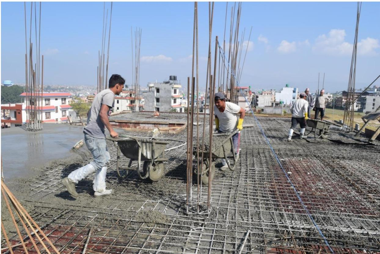
*Foto: Betonierarbeiten an einer Bramme*
